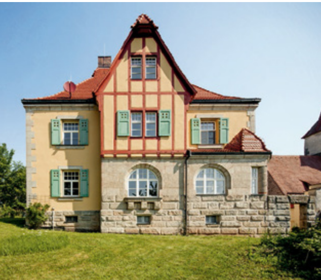
Pfarrhaus in Laubendorf, erbaut 1904/05 (Foto Gerhard Hagen)
