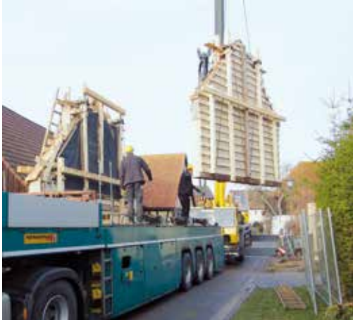
11 Abbau und Abtransport des Ottenhofener Behelfsheimes im Dezember 2015. Die Versetzung erfolgte in vier ganzen Wandteilen und zwei Teilen der Dachkonstruktion. Foto: Markus Rodenberg
