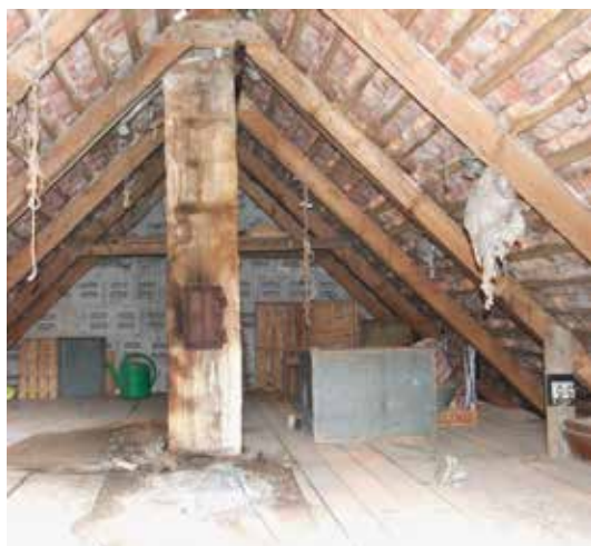
6|44 Blick in den Dachraum mit waagrecht aufgemauerten Bimshohlblöcken. Foto: Markus Rodenberg
